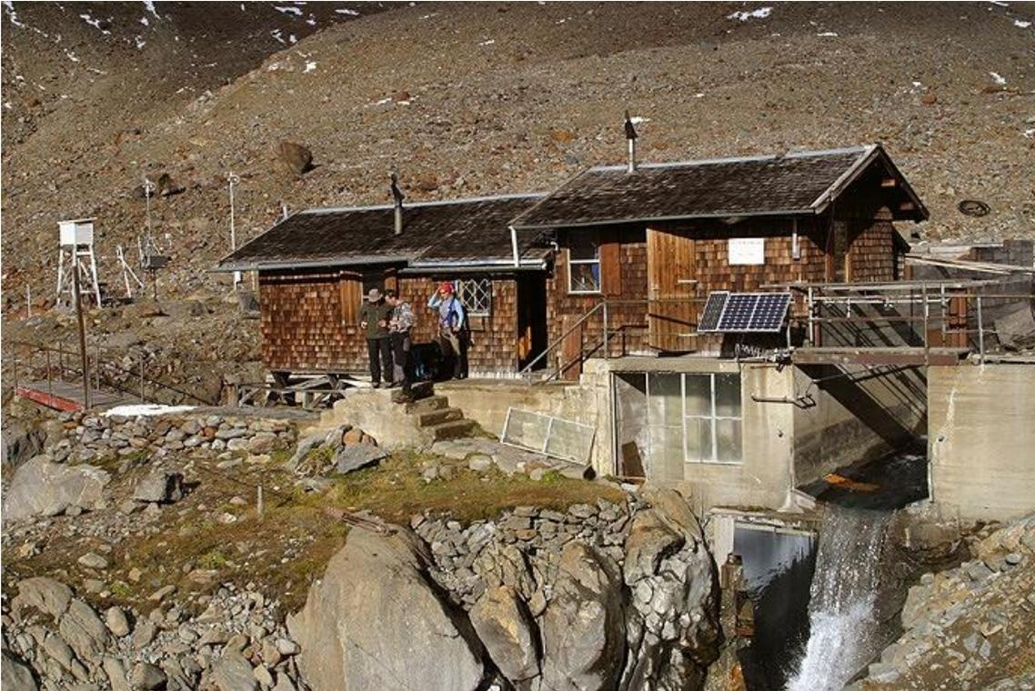
Abbildung 7: Pegelstation Vernagtbach mit Abflussgerinne bei geringem Abfluss. Foto: L. Braun, KFG 2004.
